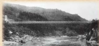
完成した頃の明神橋(大正12年)
