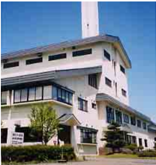
現在の環境センター山都工場
