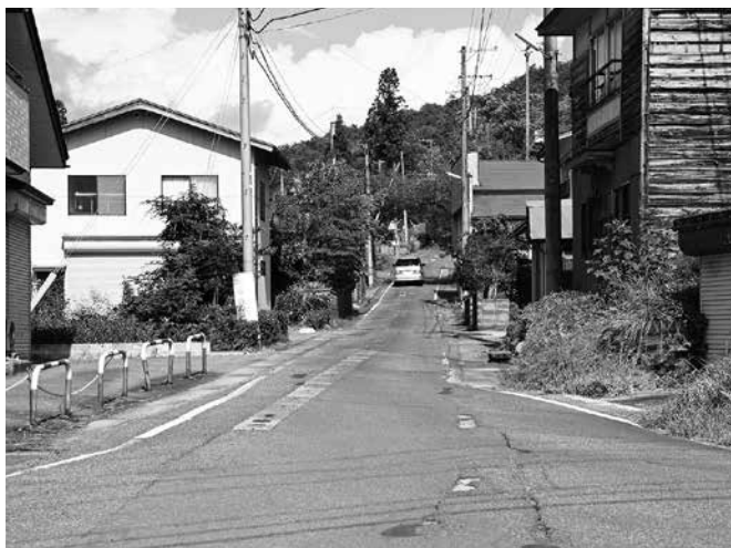
幅員が狭く路面も荒れている 樟山地区内の道路
