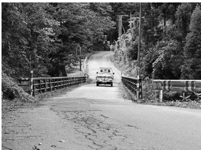
幅員が狭く勾配がきつい 牧橋とその前後の道路
