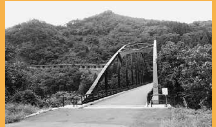
明神橋耐震補強工事1億3,487万円
