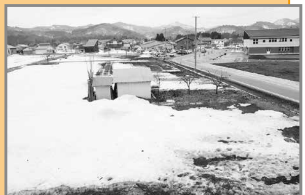
早期完成が望まれる 認定こども園建設予定地
