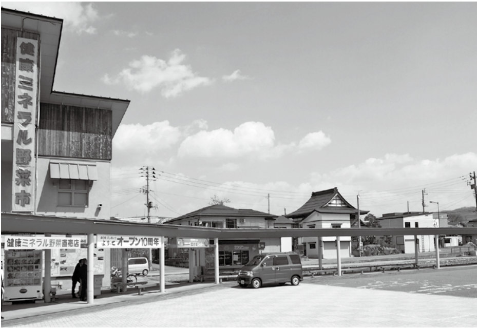
地域連携販売力強化施設が整備される商業団地A区画
