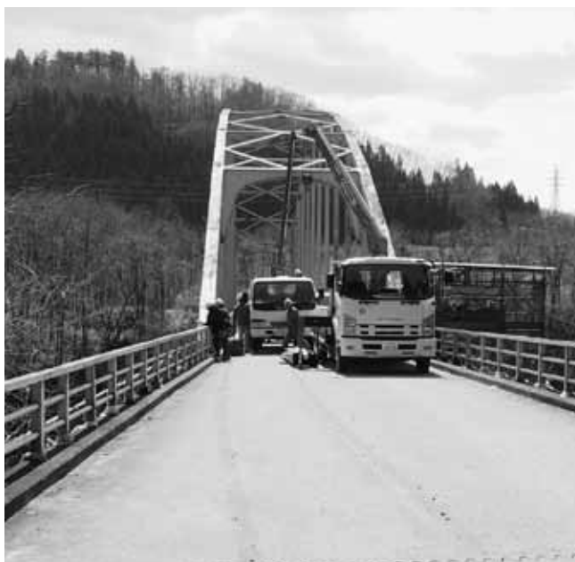
今後は終日の交通規制も（明神橋耐震補強工事）
