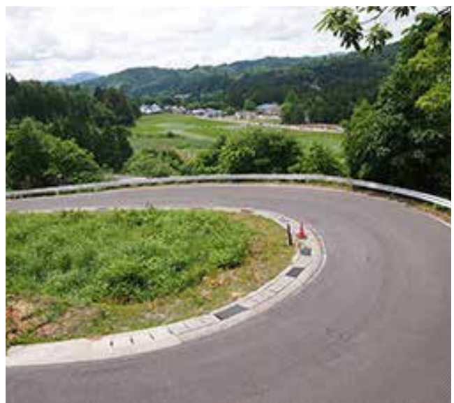
カーブがきつく、道も狭い奥川中町地内
