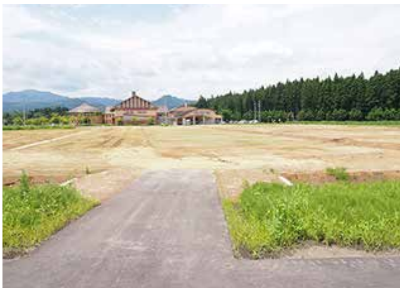
敷地造成工事が完了した小学校建設予定地
