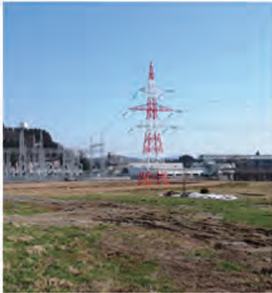
上野尻発電所から阿賀町へ伸びる送電線
