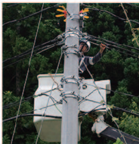
ケーブルテレビ高度化事業第2期工事
