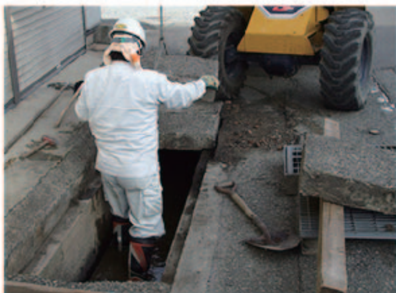
流雪溝に堆積した土砂の撤去
