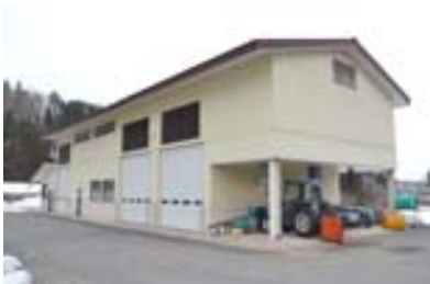
機能強化される奥川ライスセンター
