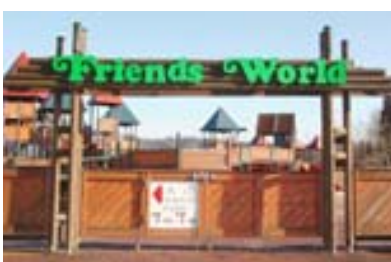
フレンズワールドの遊具を改修
