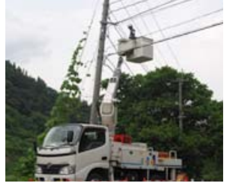
ケーブルテレビ高度化事業 第2期工事のようす
