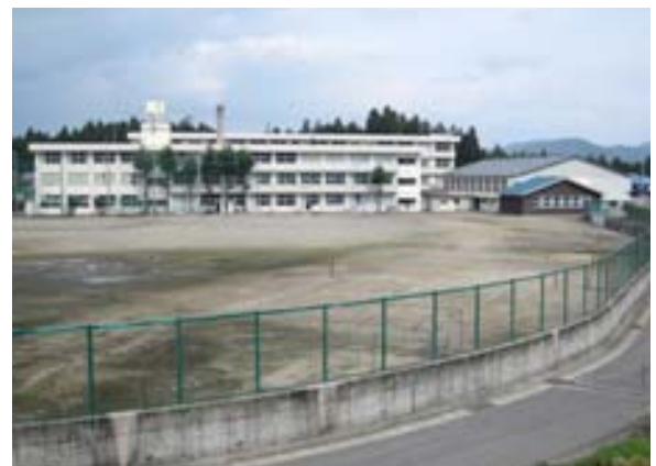
西会津高校の活性化が望まれる
