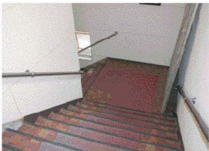
左側の壁に昇降機を設置予定（町公民館新館）
