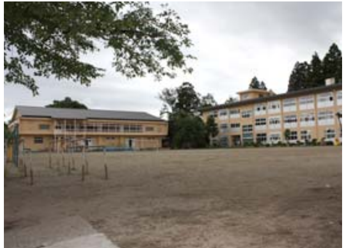
耐震補強工事が完了した野沢小学校
