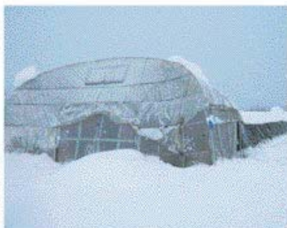
12月の大雪で倒壊したパイプハウス
