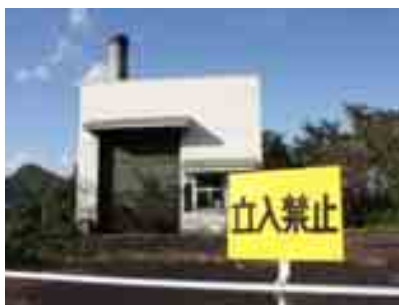
解体される環境センター 西会津分工場
