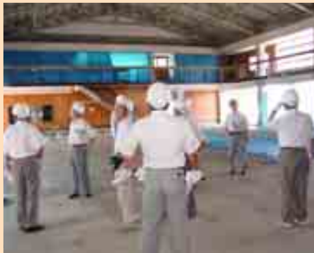
耐震補強工事中の 野沢小体育館
