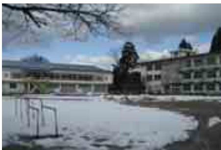
耐震補強工事が待たれる
