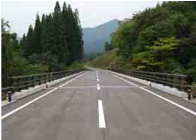
平成19年度に完成した町道野沢柴崎線橋立1号橋
