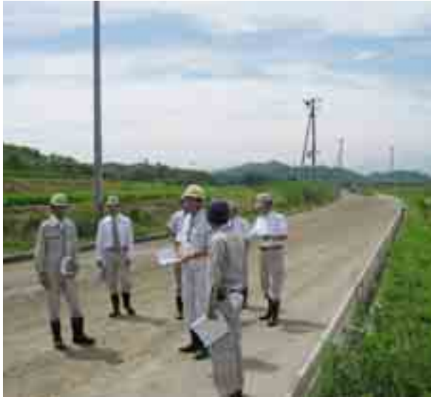
整備中の町縦貫道路
