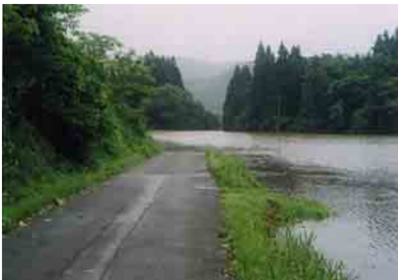
冠水した端村線
