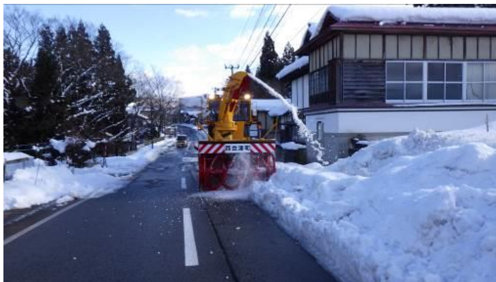
[道路除雪：野沢地区]
