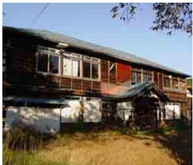
解体される高陽根分校
