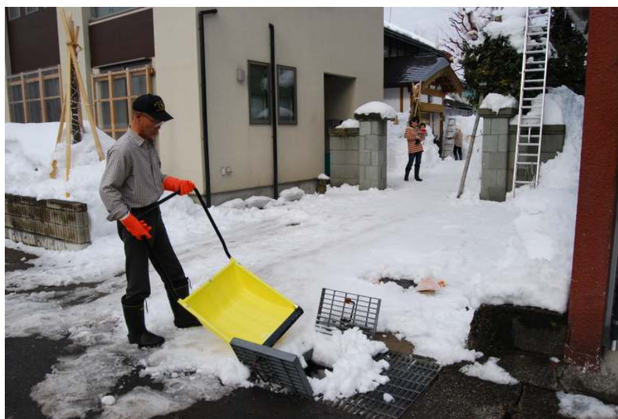
[流雪溝への投雪作業：野沢地区]
