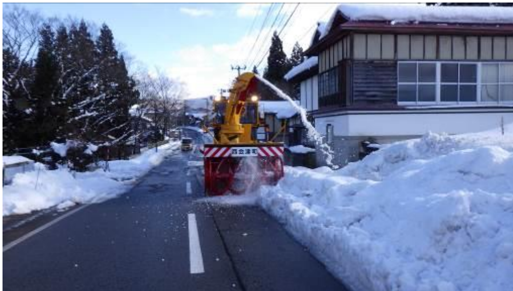
[道路除雪：野沢地区]
