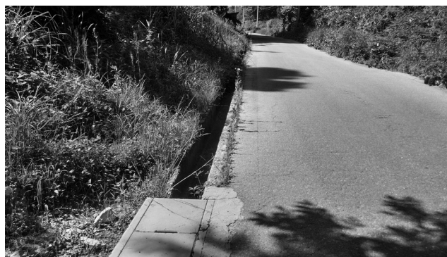
蓋のない側溝の一例
