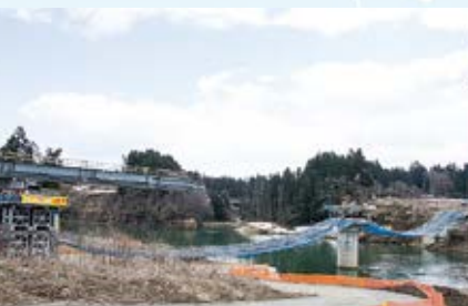
▲県代行事業で架け替えられる橋屋橋 (本年度中に完成予定)
