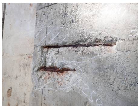
写真-6 下部工の剥離・鉄筋露出
