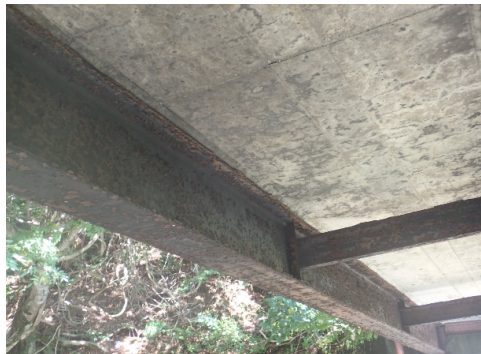
写真-2 鋼桁の塗装劣化
