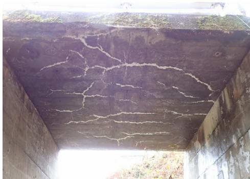
写真-5 RC橋 床版ひびわれ
