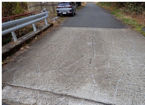
写真-8 舗装のひびわれ
