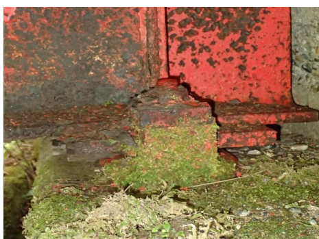
写真-3 支承の腐食
