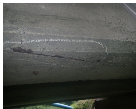
写真-4 RC橋 主桁の鉄筋露出
