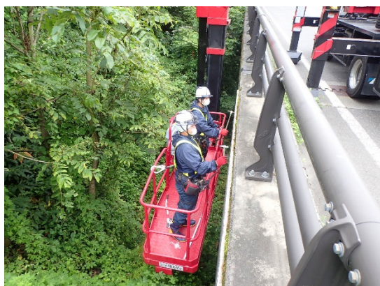
橋梁点検車での点検
