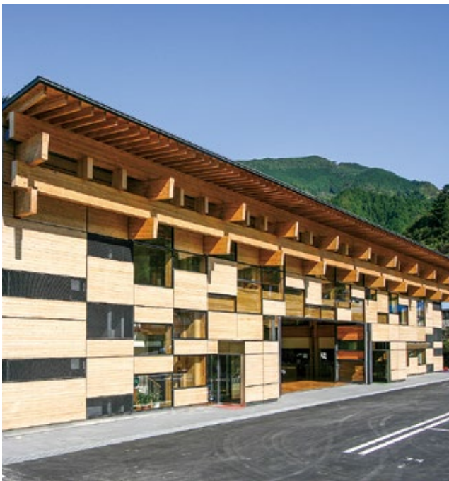
▲CLT材で建築された高知県梶原町の役場庁舎 (写真提供=高知県梶原町)
