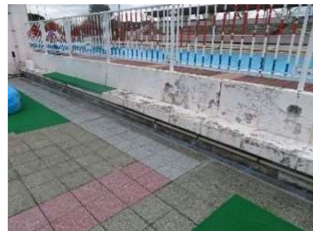
屋外プール(幼児) コンクリートの ひび割れ
