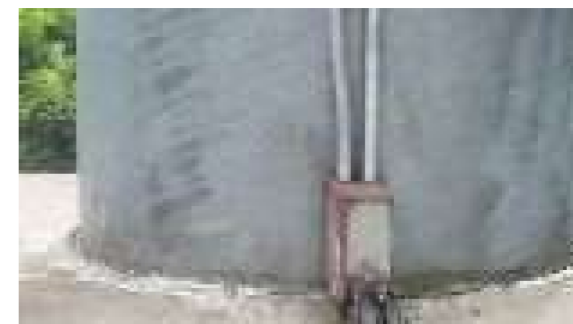
野球場屋外照明灯(健全度C) 基礎のシーリング切れ、照明の点灯不良
