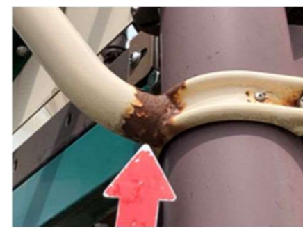
展望複合遊具 継手金具の腐食
