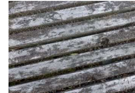
六角小屋(大) 野地板の腐朽
