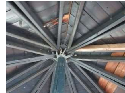
六角小屋(大) 野地板の腐朽
