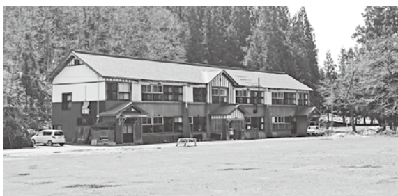
西会津国際芸術村改修工事 5,098万円 (スプリンクラー設置、飲食施設改修など)
