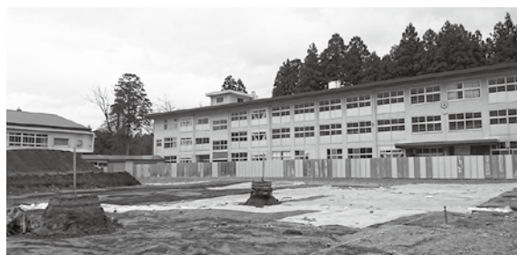
役場新庁舎改修等工事 4億4,045万円 (3月定例会で工事請負契約締結を可決)
