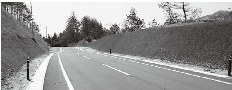
戸中～橋立間の道幅が広がり見通しもよくなる。
