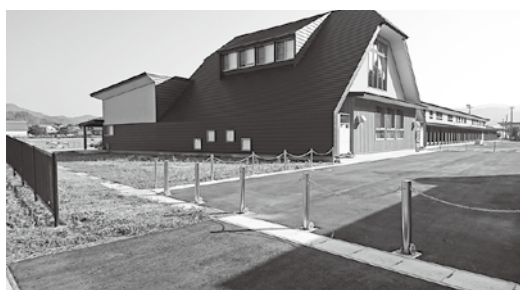
ボイラー室周辺の隙間にフェンスを設置
