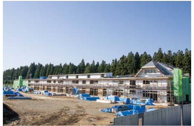
▲こゆりこども園の工事状況(平成28年11月12日撮影)
