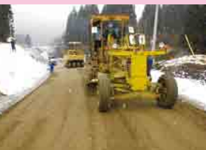
▲昨年度の町道下野尻端村線・舗装工事
