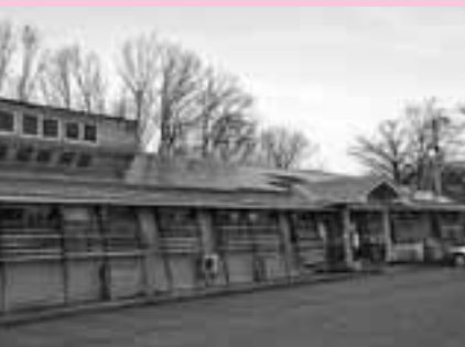
▲太陽光発電施設を設置した西会津診療所
