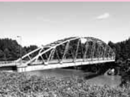
▲県代行事業で架け替えられる橋屋橋
