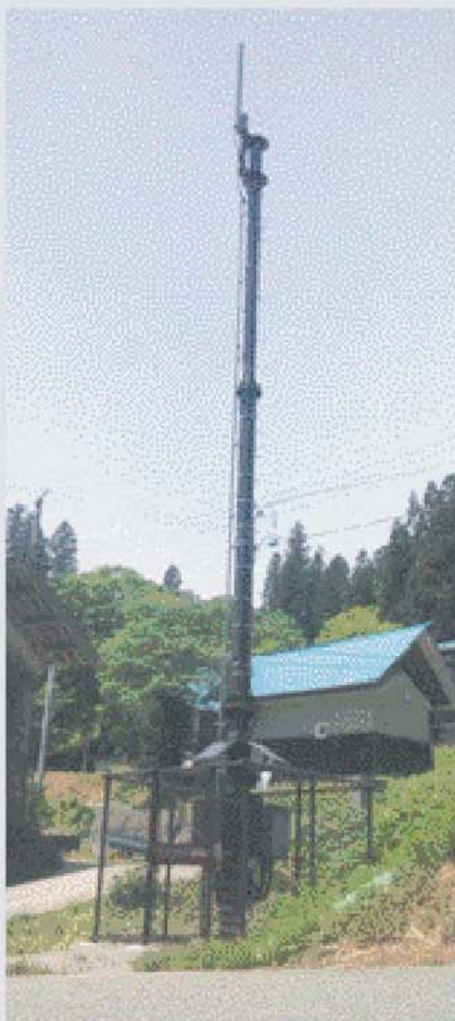
今回整備した簡易鉄塔（井谷）
