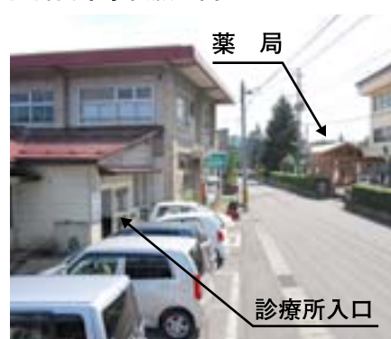
群岡診療所側の調剤薬局 旧群岡中学校敷地内
