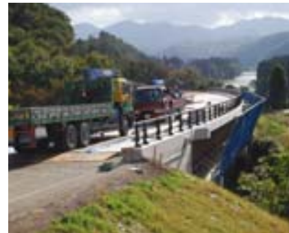
整備が進む縦貫道路
