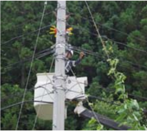
光ケーブル張り替え中
