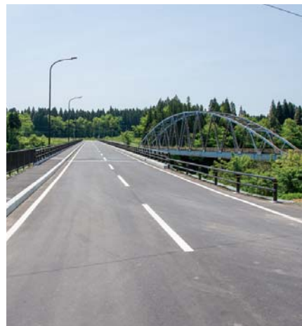
完成した橋屋橋（右奥は旧橋屋橋）
