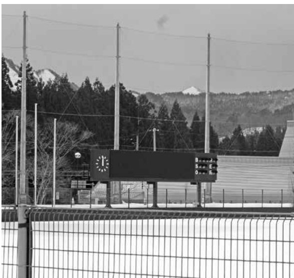
完成した野球場スコアボード
