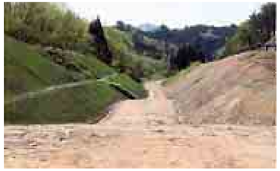
改築工事が進められている中町峠
