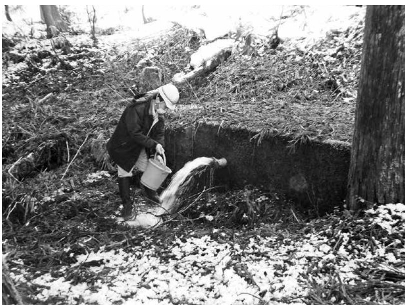
早く飲料水の安定供給に取り組んでほしい（黒沢水源地調査）
