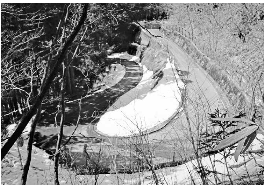
通年通行の早期実現で連携強化を（国道400号杉峠の急カーブ）
