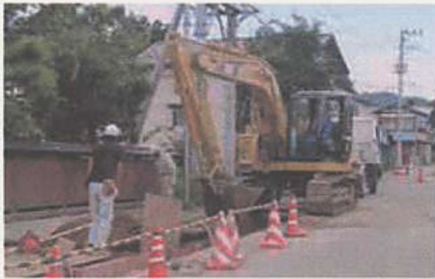
▶上野尻地区の管路工事
