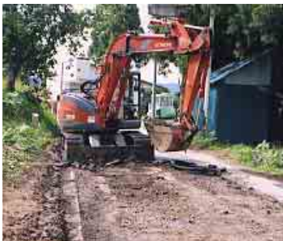
◀ 笹川地内の農業集落排水管路工事
