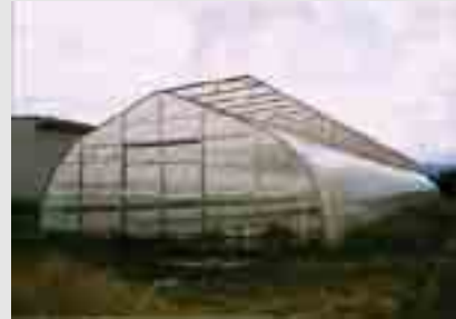
▲耐雪型パイプハウス
