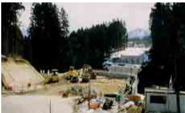
工事が進められる芝草橋屋線
