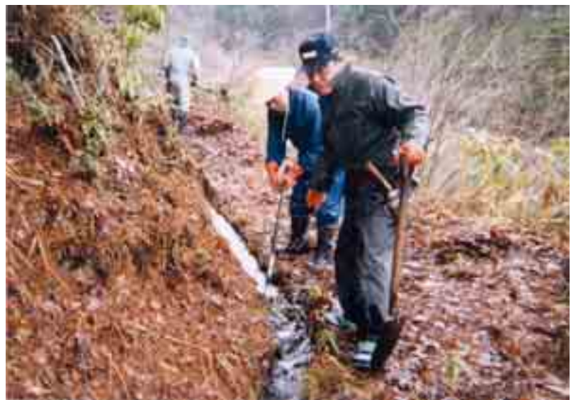
塩集落で取り組んだ水路工事
