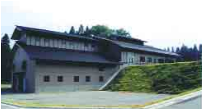
平成12年度に供用開始した野沢浄化センター
