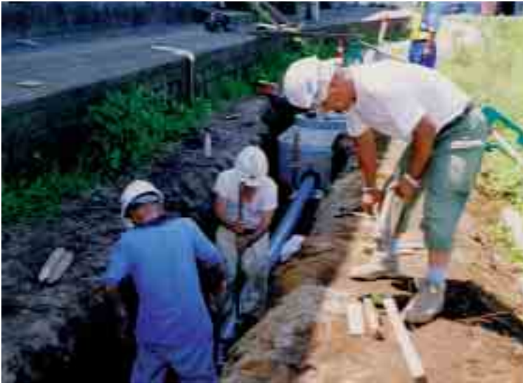
野沢下小屋で進められる下水道管埋設工事
