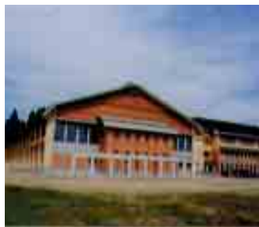
会津中学校屋内運動場（体育館）
