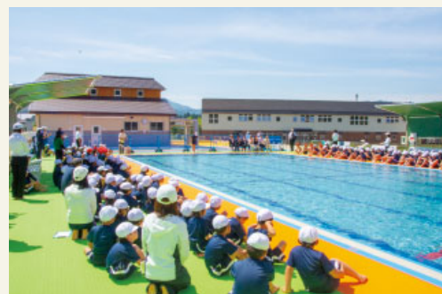
6月に完成した小学校プール
