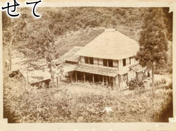
正中鉱泉にあった「滴翠館」(明治 36 年撮影)
