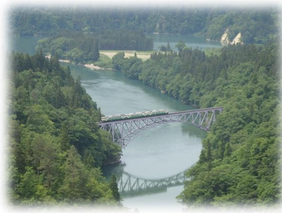
第一只見川橋梁
