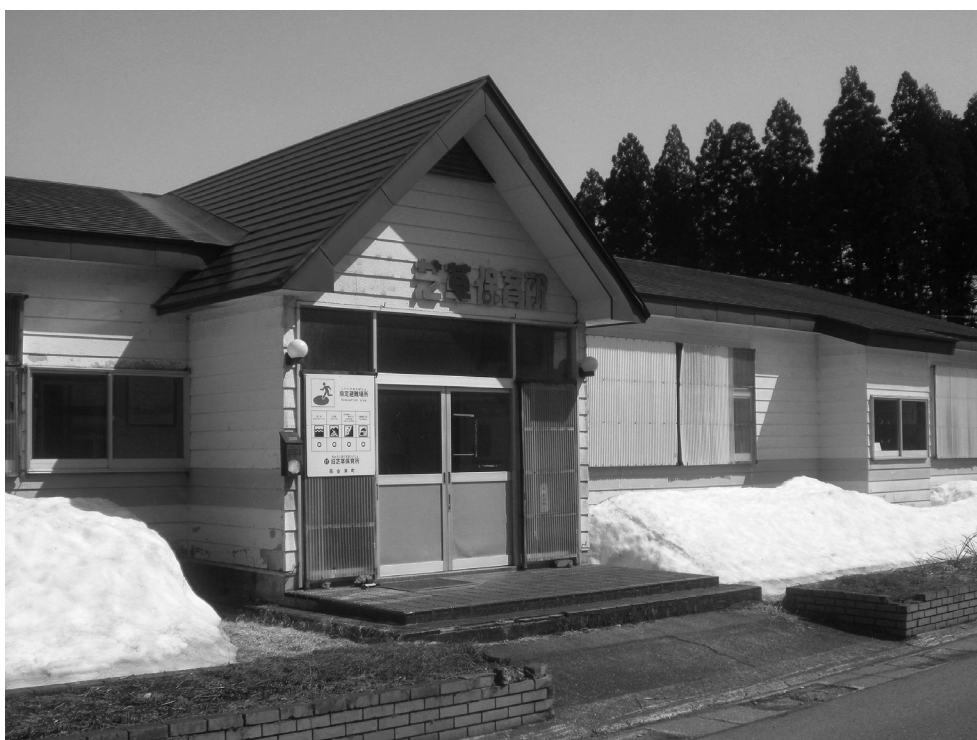
子育てコミュニティ施設に改修される旧芝草保育所
